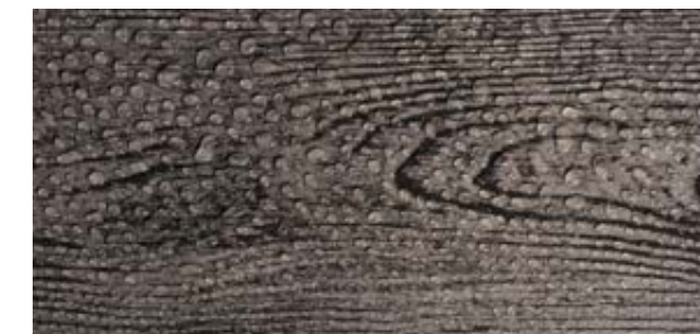
POVRCH DLAŽBY S ÚPRAVOU DEP
